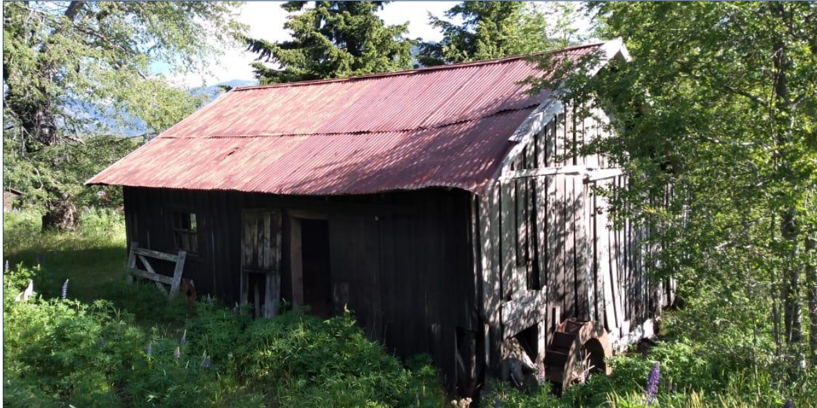
Figura 12. Sala de Máquinas (aserradero); RN. Malalcahuello.
