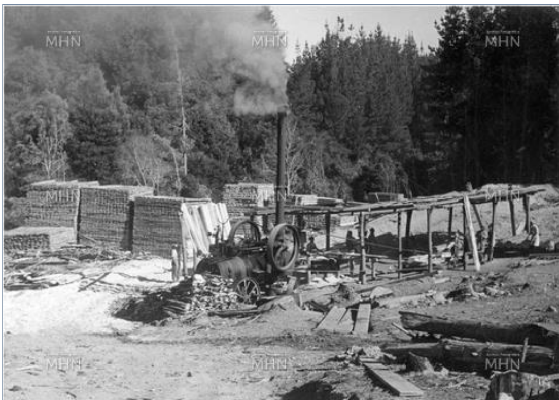
Figura 11. Locomovil instalado en aserradero de madera nativa; comuna de Curacautín.
