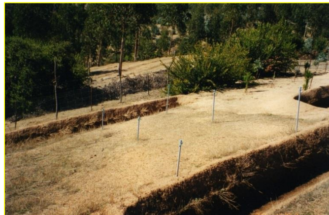
ZANJA DE INFILTRACIÓN
