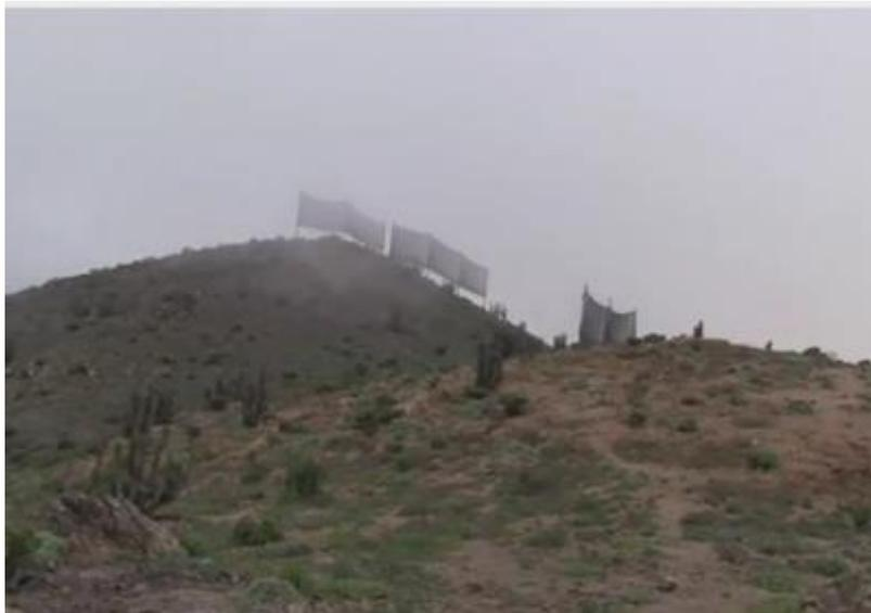
El poblado de Falda Verde, en el desierto de Atacama, utiliza un sistema para captar el agua de la camanchaca. El “Atrapa Nieblas” es un sistema de mallas que atrapan y recogen las gotas de agua de la neblina
