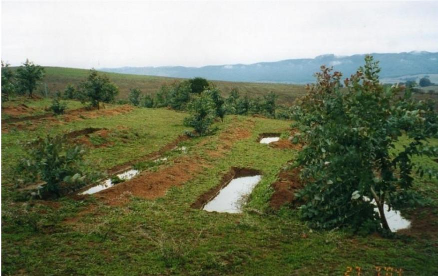
Área del perfil transversal  $0,108 \text{ m}^2$ , de base 20 cm, ancho superior 52 cm, altura 30 cm, proporción talud aguas arriba 1:0,57, largo 30 cm y proporción talud aguas abajo 1:0,50, largo 32,5 cm. De largo 3 m, capacidad en volumen  $0,324 \text{ m}^3$  y una distancia entre zanjas de 6 m, resultando un área de captación de aguas lluvias de  $18 \text{ m}^2$ .
