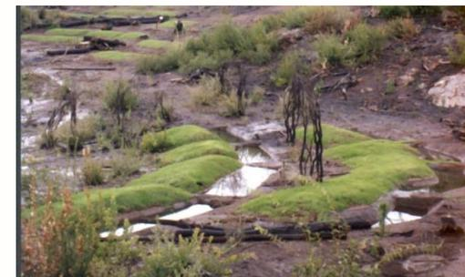
Zanja de Infiltración
