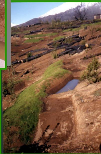
Gran acumulación de sedimentos en zanja de infiltración
