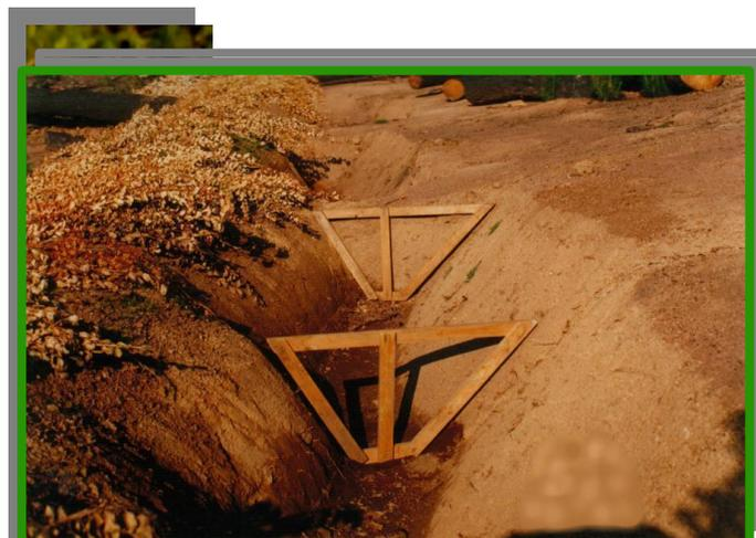
Vista en detalle de zanja de infiltración trazada en sentido de curva de nivel. En el interior matriz utilizada en la verificación de las dimensiones
