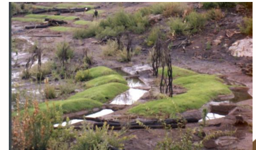
Zanja de Infiltración
