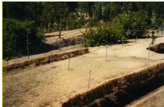
ZANJA DE INFILTRACIÓN
