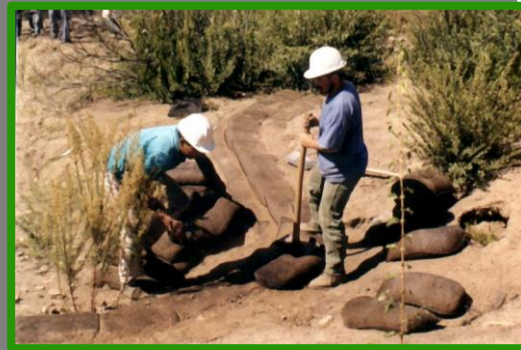
Construcción de curva de nivel con sacos en terreno inestable, susceptible de sufrir erosión
