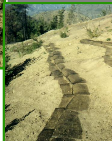
Vista en perspectiva de ladera tratada con sistema de curvas de nivel
