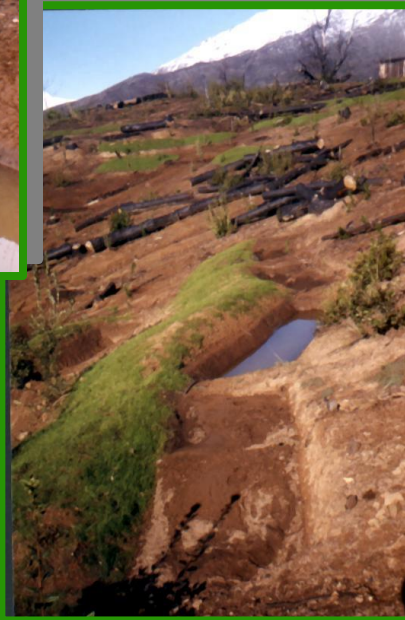
Gran acumulación de sedimentos en zanja de infiltración
