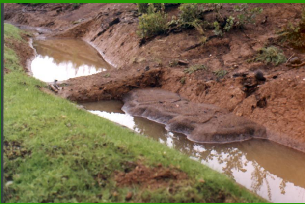
Vista en detalle de Zanja de Infiltración , con gran acumulación de aguas de escorrentía superficial
