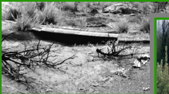
Secuencia de fotos que muestran liman con retención de sedimentos y flujo hídrico, a su vez estabilización de la pendiente.
