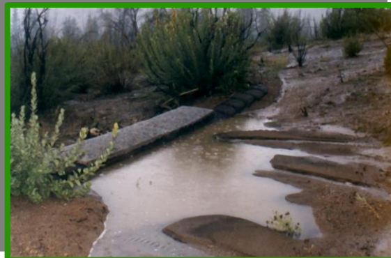
Secuencia de fotos que muestran liman con retención de sedimentos y flujo hídrico, a su vez estabilización de la pendiente.
