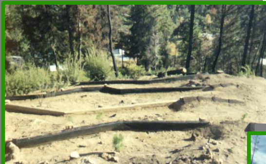
Estabilización de ladera altamente inestable por medio de empalizada
