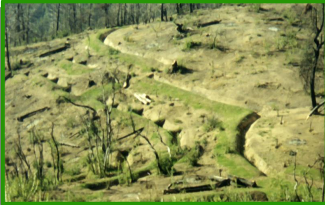
Vista panorámica de canales de desviación, disminuyendo presión erosiva sobre ladera inestable
