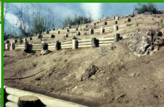
Vista frontal de ladera inestable tratada con empalizada
