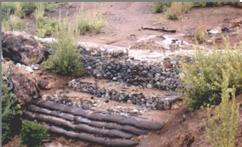
Vista General de dique de gaviones funcionando su represa así como dissipador de energía complementado con muros de sacos
