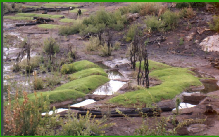
Vista de sistema de zanj as dispuesta en tres bolillo, es decir entrecruzada en el sentido de la pendiente de manera de infiltrar toda el agua escorrentía de la zona tratada
