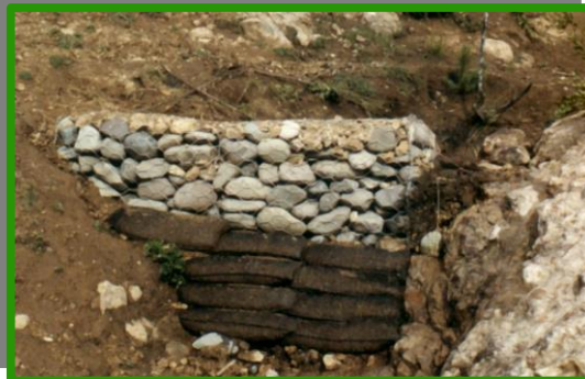
Vista en detalle de muro de saco como obra complementaria a estructura gavionada
