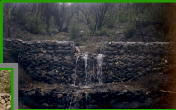
Diques de Gaviones, regulando flujo hídrico en microcuenca N°3
