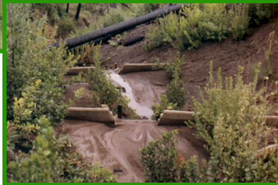
Vista de sistema de diques en cauce, reteniendo sedimentos y regulando flujo hídrico
