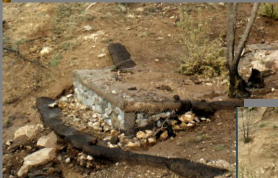
Vista en primer plano de liman construido malla gallinera
