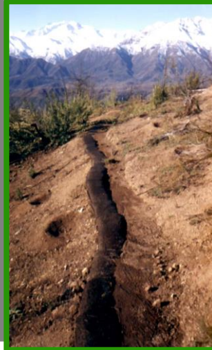
Secuencia de foto que muestra terrazza revestida con saco, con sedimento retenido
