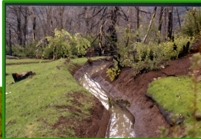
Vertedero, sección de entrega de aguas que fluyen por el canal de desviación
