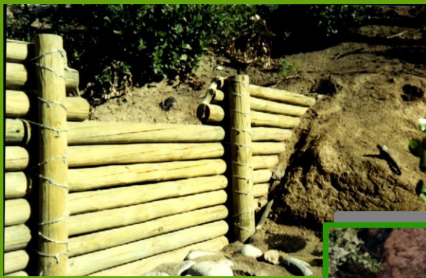
Dique de poste de pino impregnado, en detalle se muestra la importancia de un correcto empotrado lateral.
