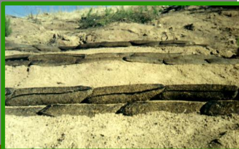
Vista en detalle de curvas de nivel con sacos, en estabilización de ladera
