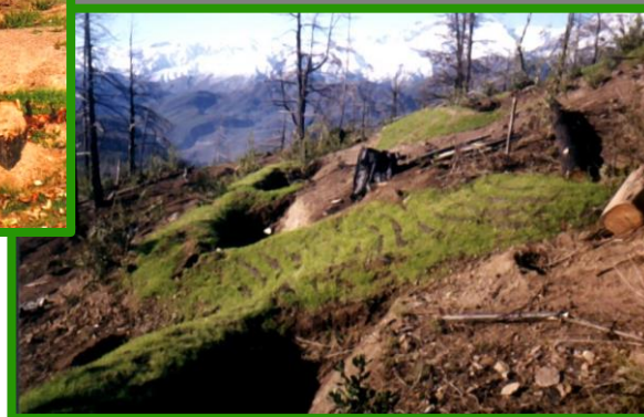
Siembra de pasto como complemento a obra de conservación (muros de sacos)
