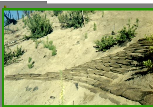
Vista de Muros de sacos en ladera altamente inestable.
