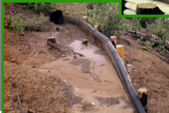
Acumulación de sedimentos en empalizada dispuesta terreno erodable
