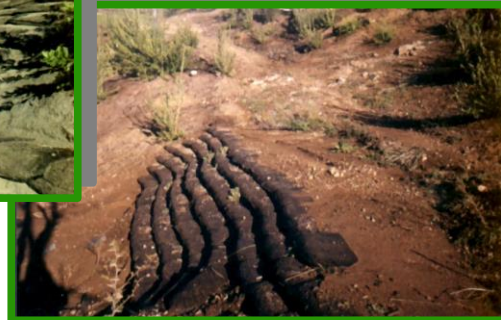
Muro de sacos en terreno erodable, con acumulación de sedimentos en parte superior
