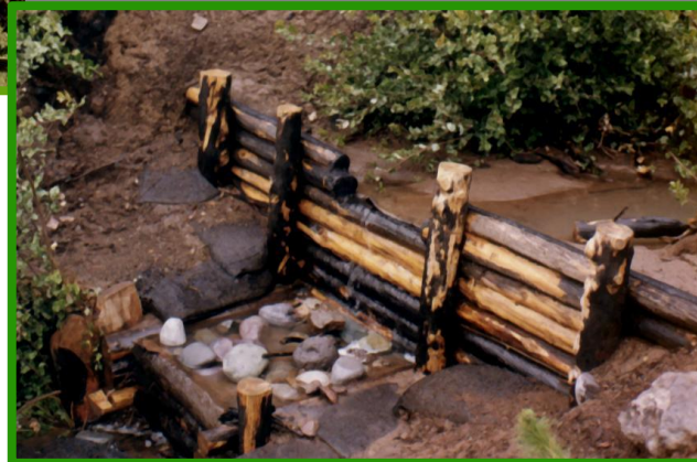
Dique de poste de pino impregnado, en detalle se muestra la importancia de un correcto empotrado lateral.
