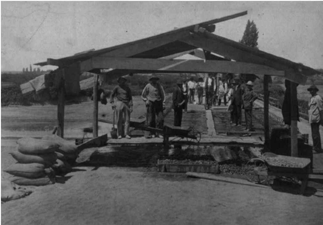
Trabajadores en la construcción de un puente en Cauquenes, c. 1922. Archivo Fotográfico Museo Histórico Nacional de Chile.
