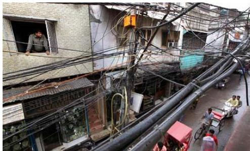
En muchos casos, las mejoras que se intentan se neutralizan ante una red intrincada, colapsada por los enredos de cables callejeros, muchos de ellos son conexiones ilegales que hurtan electricidad y causan fugas de tensión gigantescas.
