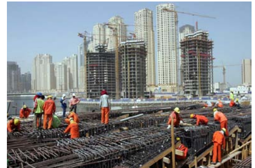
Construcción en el área de nuevo desarrollo, en Mumbai
