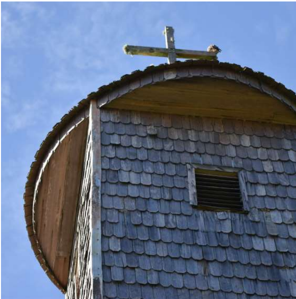
Fotografía 5. Chapitel de la torre visto desde abajo.
