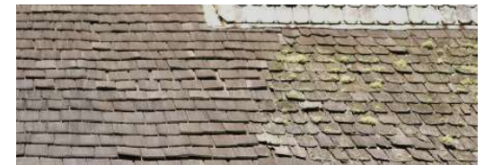
Fotografía 9.7. Cubierta sin restaurar.
