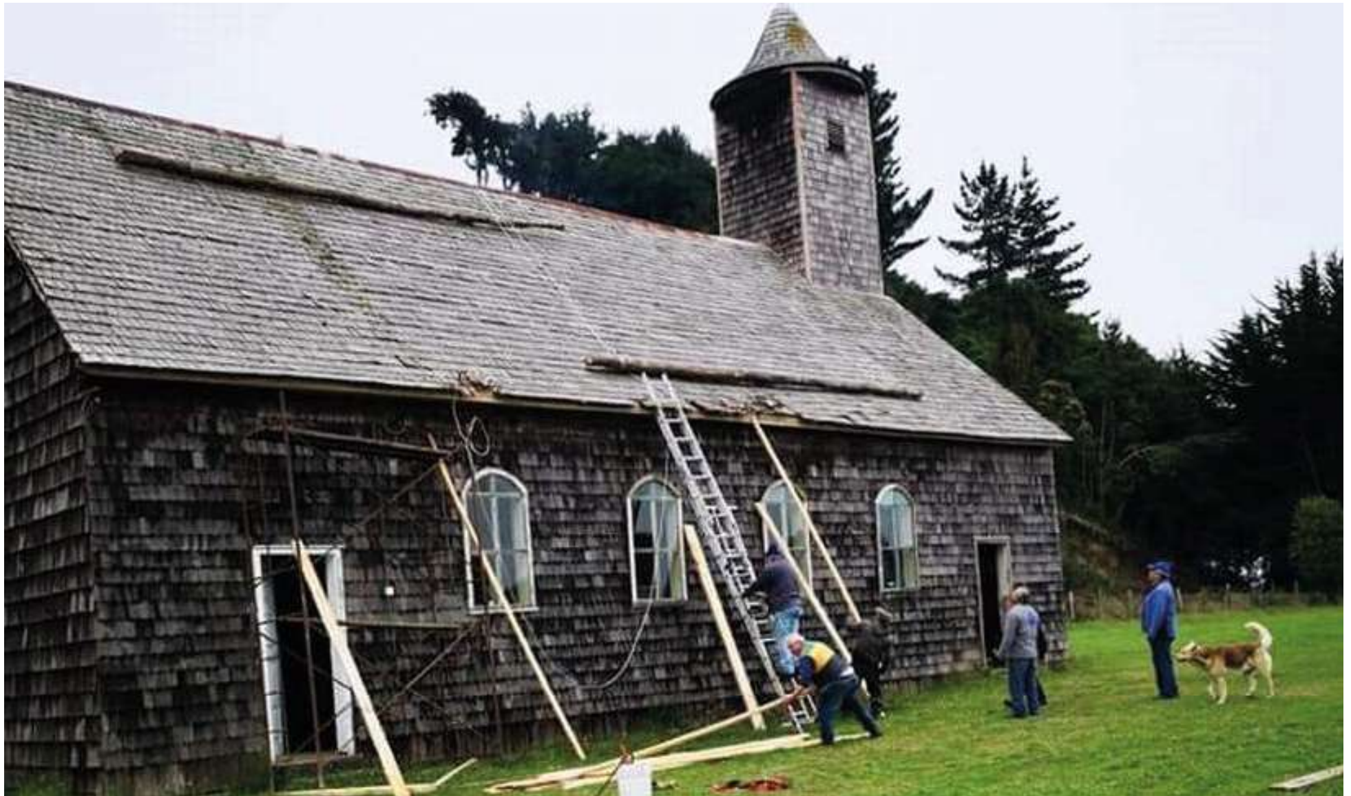
Fotografía 12. Minga para la reparación de la iglesia en Caulín. Fuente: SoyChile.cl
