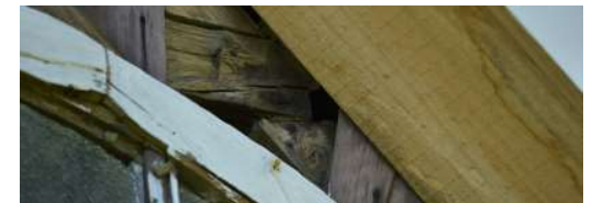
Fotografía 9.5. Chiflonera: humedades y huecos en el revestimiento.
