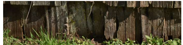
Fotografía 9.2. Daños en el revestimiento de las fundaciones.
