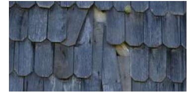
Fotografía 9.2. Daños en el revestimiento de las fundaciones.
