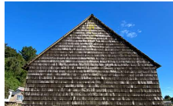
Fotografía 2.2. Fachada Lateral Izquierda.
