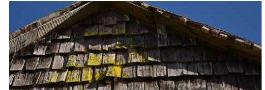
Fotografía 9.5. Chiflonera: humedades y huecos en el revestimiento.
