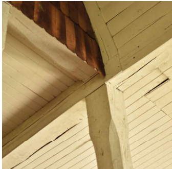
Fotografía 10.3. Láminas de madera levantadas.
