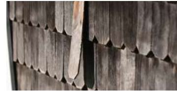
Fotografía 9.2. Daños en el revestimiento de las fundaciones.
