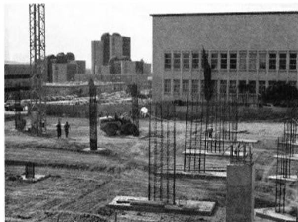
Las armaduras de espera de los pilares sobresalen de los encepados: los de la derecha sobre tres pilotes, los centrales sobre dos y los de la izquierda sobre uno.
