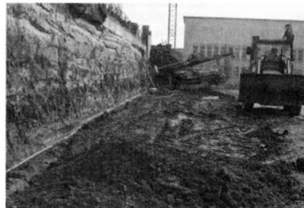
Una vez acabado el muro y hecho un primer rebaje de tierras, la perforadora está preparando el anclaje del muro al terreno.
