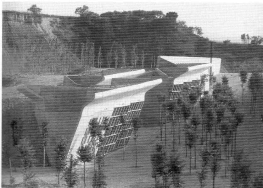
3. El cementerio de Igualada, de E. Miralles, explota las posibilidades de conformación del hormigón a partir de un simple molde de acero.
