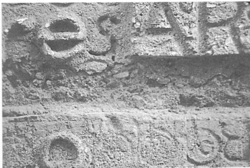
12. Sólo un intenso vibrado y una granulometría estudiadísima pueden hacer posible la precisión de este moldeo sobre el encofrado esculpido por Subirachs para el edificio Telexprés de Barcelona (Esquius y Puig).
