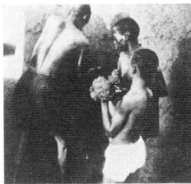
2. La plasticidad del material guía todo el proceso de puesta en obra. El transporte de arcilla en las manos de estos constructores africanos, por ejemplo, exige a la masa una gran consistencia.
