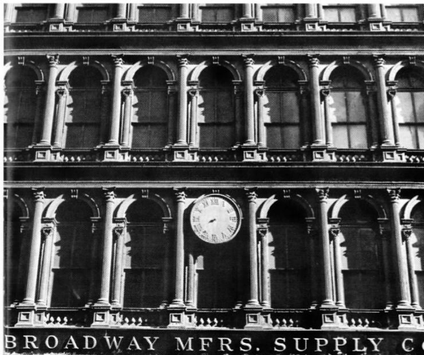
1. Las clásicas fachadas de fundición de Nueva York recuerdan la ductilidad formal de los materiales moldeables. Obsérvese la delgada capa de fundición que forma el moldurado de esa base.
