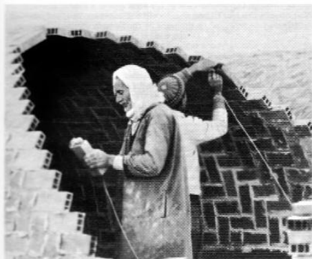
14. Los pequeños elementos se adicionan para formar elementos constructivos de mayor tamaño. La técnica más tradicional es la albañilería. La tradición artesana en el uso de pequeños elementos es vastísima. Estos alarifes tunecinos están construyendo una cáscara elíptica gracias al cordel atado a la muñeca, que les garantiza que, cuando lo tensan estirando el brazo, dibujan un círculo inclinado.
