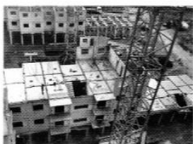
5. Las construcciones con grandes paneles, como ésta de Nadeco en Pamplona, ejemplifican los componentes. Las piezas llegan a la obra totalmente elaboradas y ningún proceso de conformación es posible. Su manipulación se reduce al montaje.
