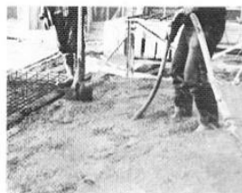
8. El total macizado del volumen que ha de ser moldeado se asegura con tratamiento de compactación. El más habitual es el vibrado.
