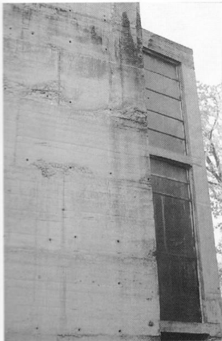
10. El convento de La Tourette ejemplifica el uso brutalista del hormigón con la textura que ofrece el más simple de los encofrados: el tablero de tablas de madera. Cada disposición de tablero y nuevo vertido supone una presión hidrostática que deforma el tablero y permite la pérdida de lechada. Esa pérdida mancha el elemento inferior y deja a la vista el árido del elemento superior.
