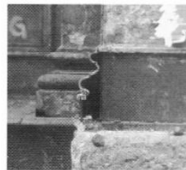
1. Las clásicas fachadas de fundición de Nueva York recuerdan la ductilidad formal de los materiales moldeables. Obsérvese la delgada capa de fundición que forma el moldurado de esa base.
