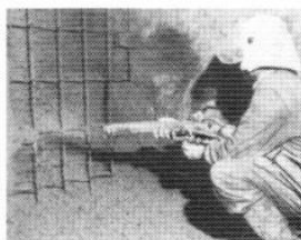
10. El proyectado es una forma de aplicación de materiales conformables en que la presión de la herramienta y la habilidad del artesano se sustituyen por la energía cinética del lanzamiento. Su uso se está extendiendo rápidamente a productos como morteros, yesos, plásticos espumados, pinturas, etc.
