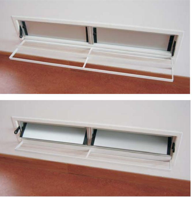
Pormenor do sistema de abertura e fecho dos orifícios de ventilação
