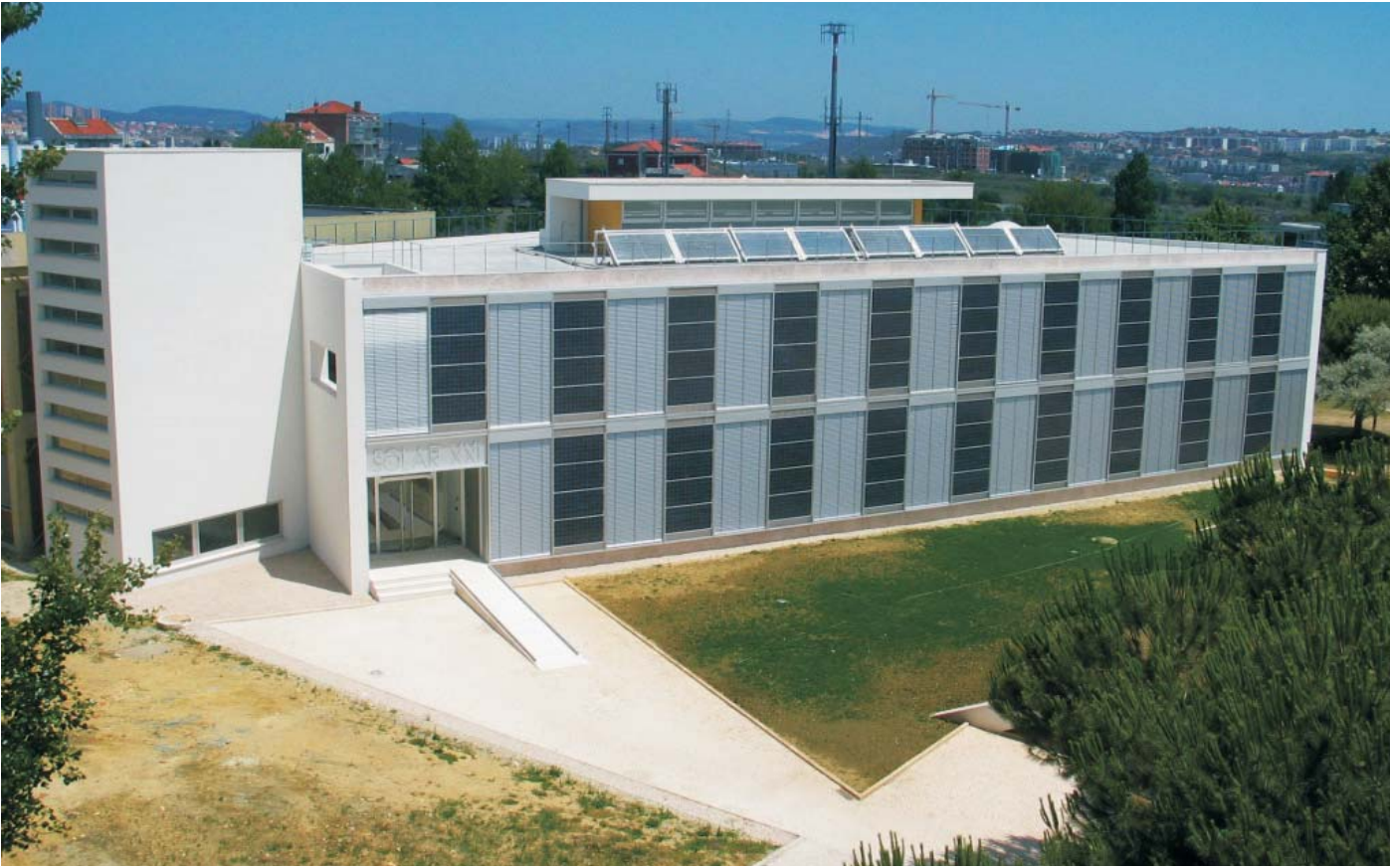
Vista geral da fachada Sul
