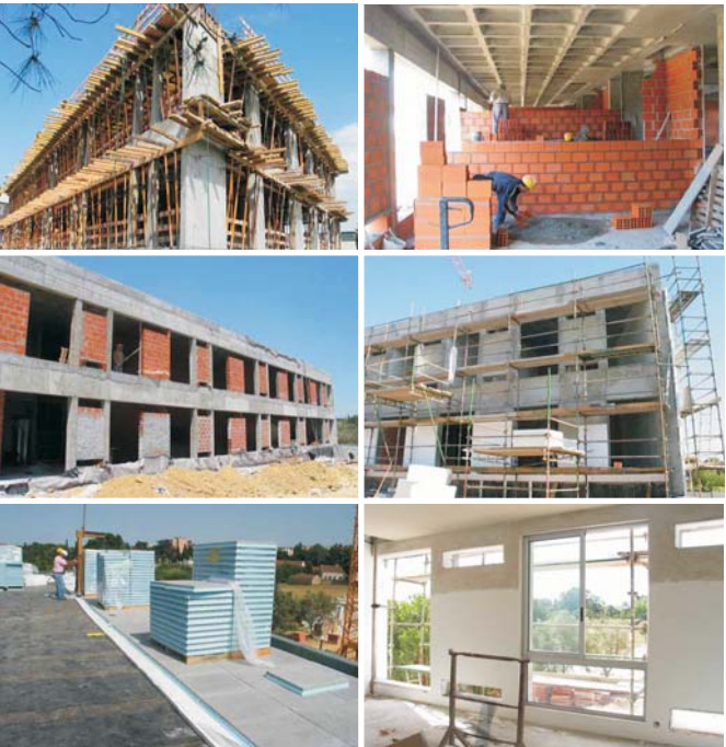
Aspectos da fase de construção
