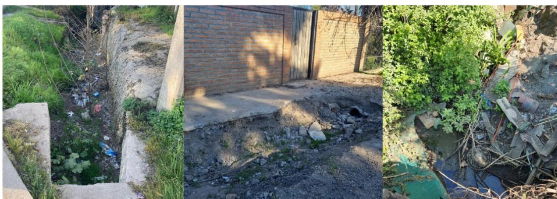
Figura 11: Recopilación de acequias bloqueadas por basura capturadas en Terreno, 2024
