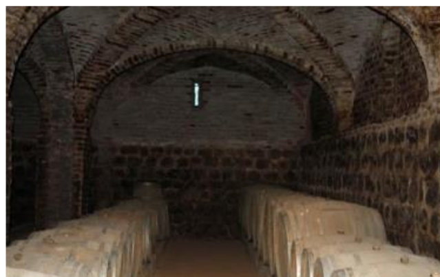
Figura N°37: Túneles Viña Santa Rita
