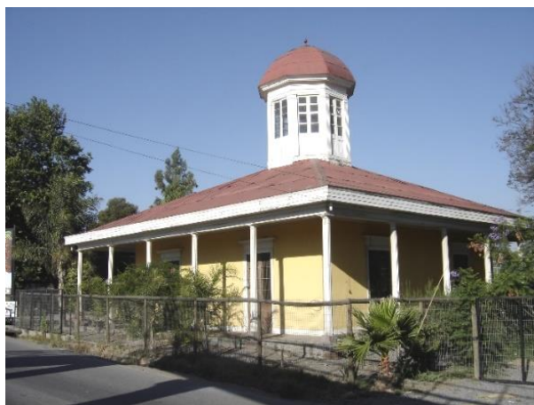
Figura N°33: Estación Los Guindos Fuente: Archivo I. M. de Buin
