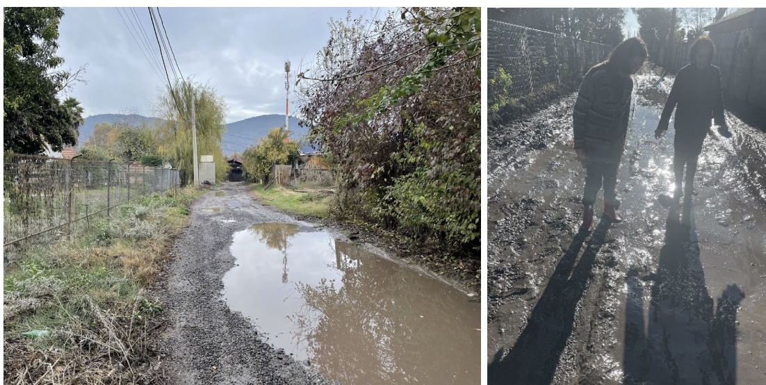
Figura 43 Calles de tierra en mal estado. Fuente: elaboración propia.
