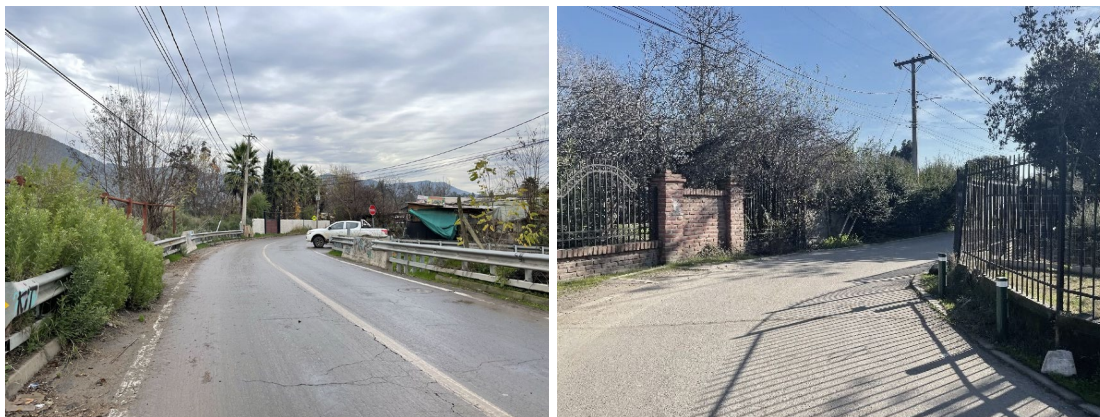
Figura 40 Calles pavimentadas sin aceras. Fuente: elaboración propia.
