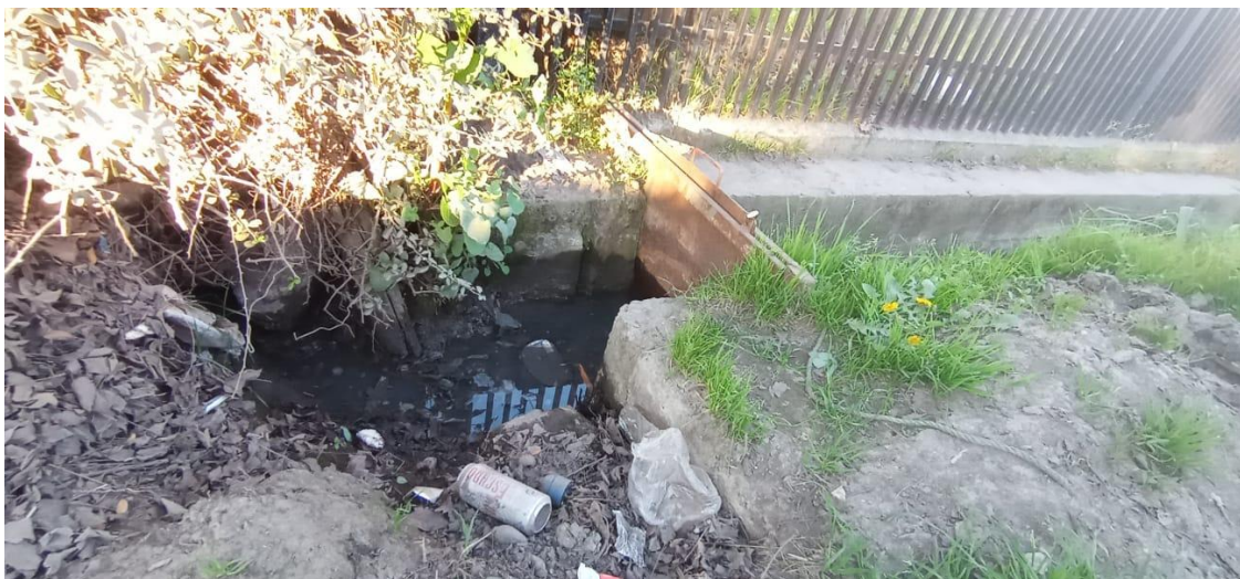
13) Destapadas recientemente producto de lluvias
