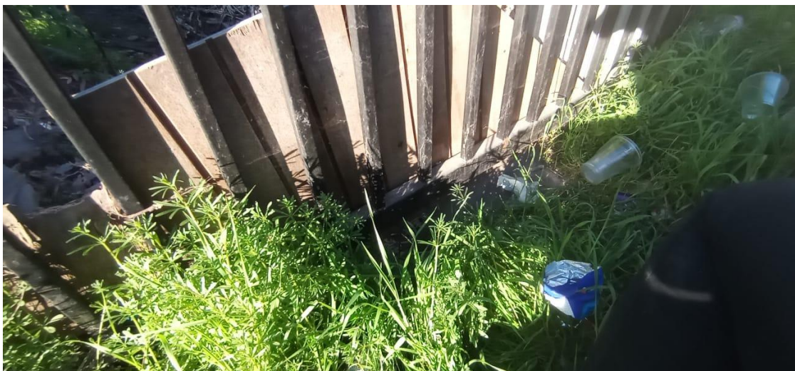
7) Destapadas recientemente producto de lluvias
