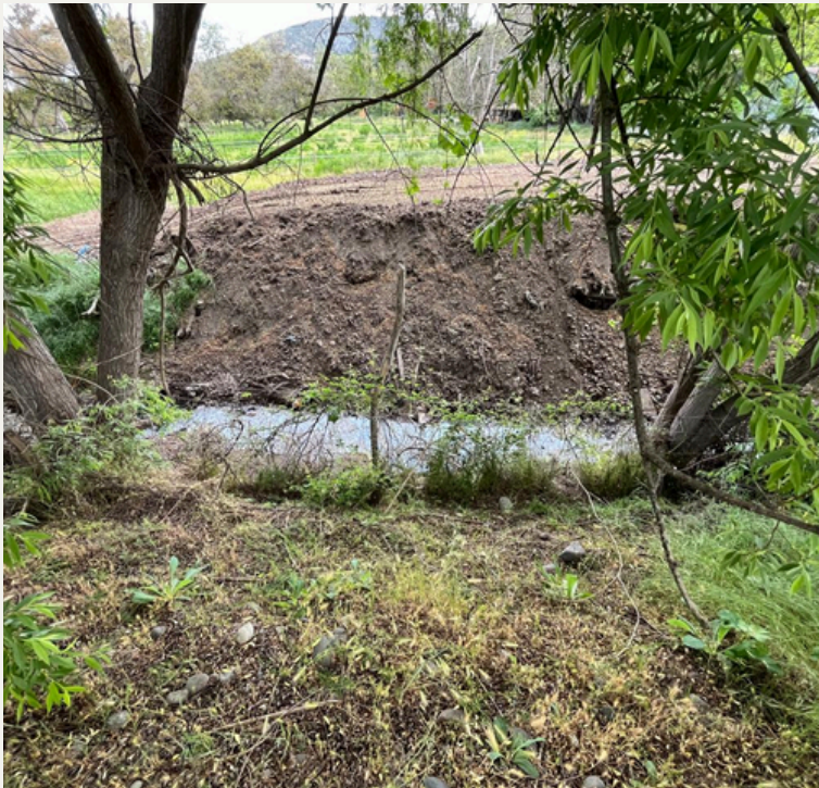
Canal de drenaje de agua lluvia.
