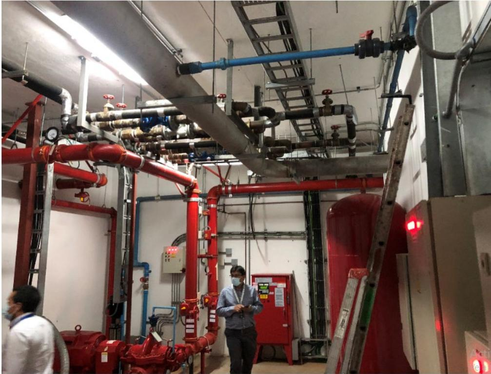
SALA DE BOMBAS DE AGUA POTABLE Y BOMBAS DE PROTECCIÓN CONTRA INCENDIO, ESTANQUES DE AGUA POTABLE. ES SUCEPTIBLE A INUNDACIONES....
