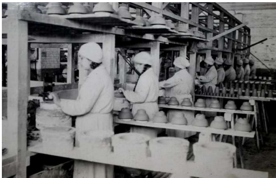
FIGURA [NÚM.10] Fabricación de aisladores, Fábrica de Cerámica de Lota, 1933.
