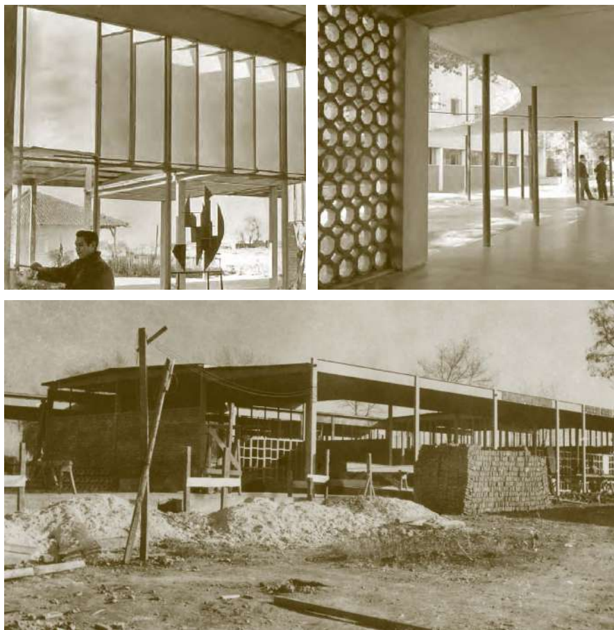
FIGURAS [NÚM. 1-3] Vistas de la construcción del edificio destinado a la Escuela de Artes Aplicadas en el campus Cerrillos, que tras la Reforma Universitaria, pasó a constituir el nuevo Departamento de Diseño.
