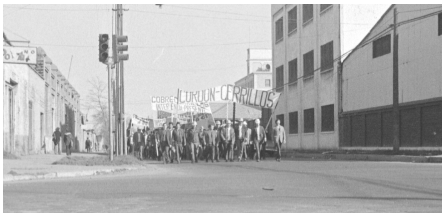
FIGURA [NÚM.28] Trabajadores obreros de la empresa Cobre Cerrillos. Cordón Industrial Cerrillos, 1973.
