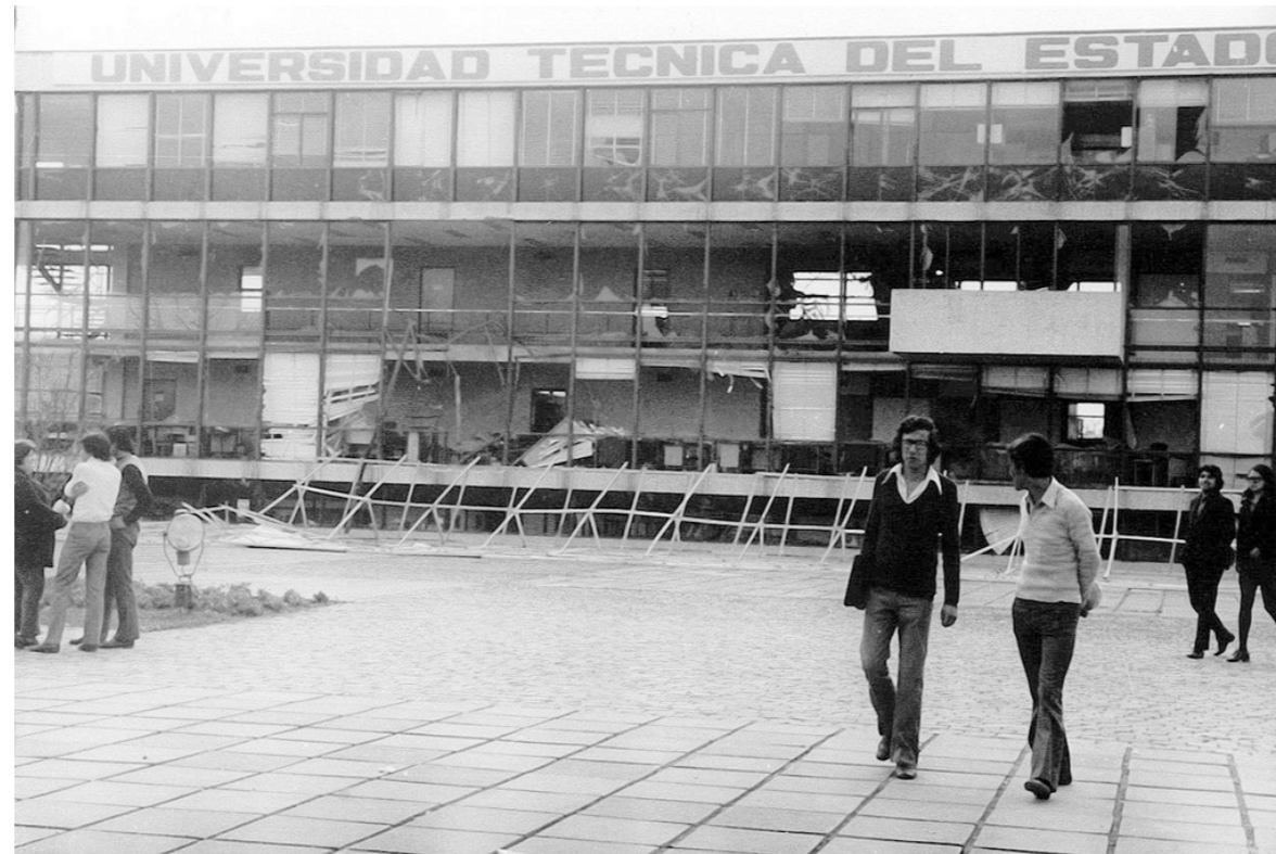
Explanada de la Casa Central de la Universidad Técnica del Estado (UTE) bombardeada después del Golpe (Fuente: http://uteusach.blogspot.cl/ )
