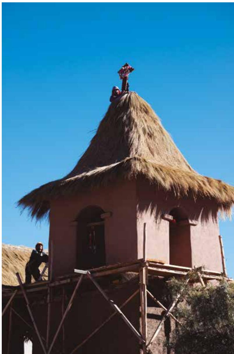
Restauración del campanario de la Iglesia de San Francisco de Asís. Restoration of the bell tower of the Church of San Francisco de Asís.
