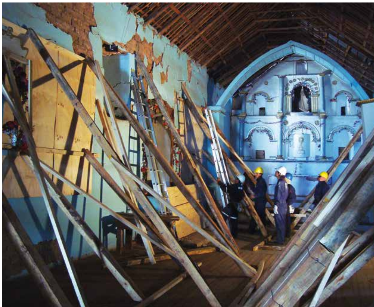
Muros apuntalados, interior de la Iglesia de San Francisco de Asís de Socorma. Underpinning of walls, interior of the Church of San Francisco de Asís of Socorma.
