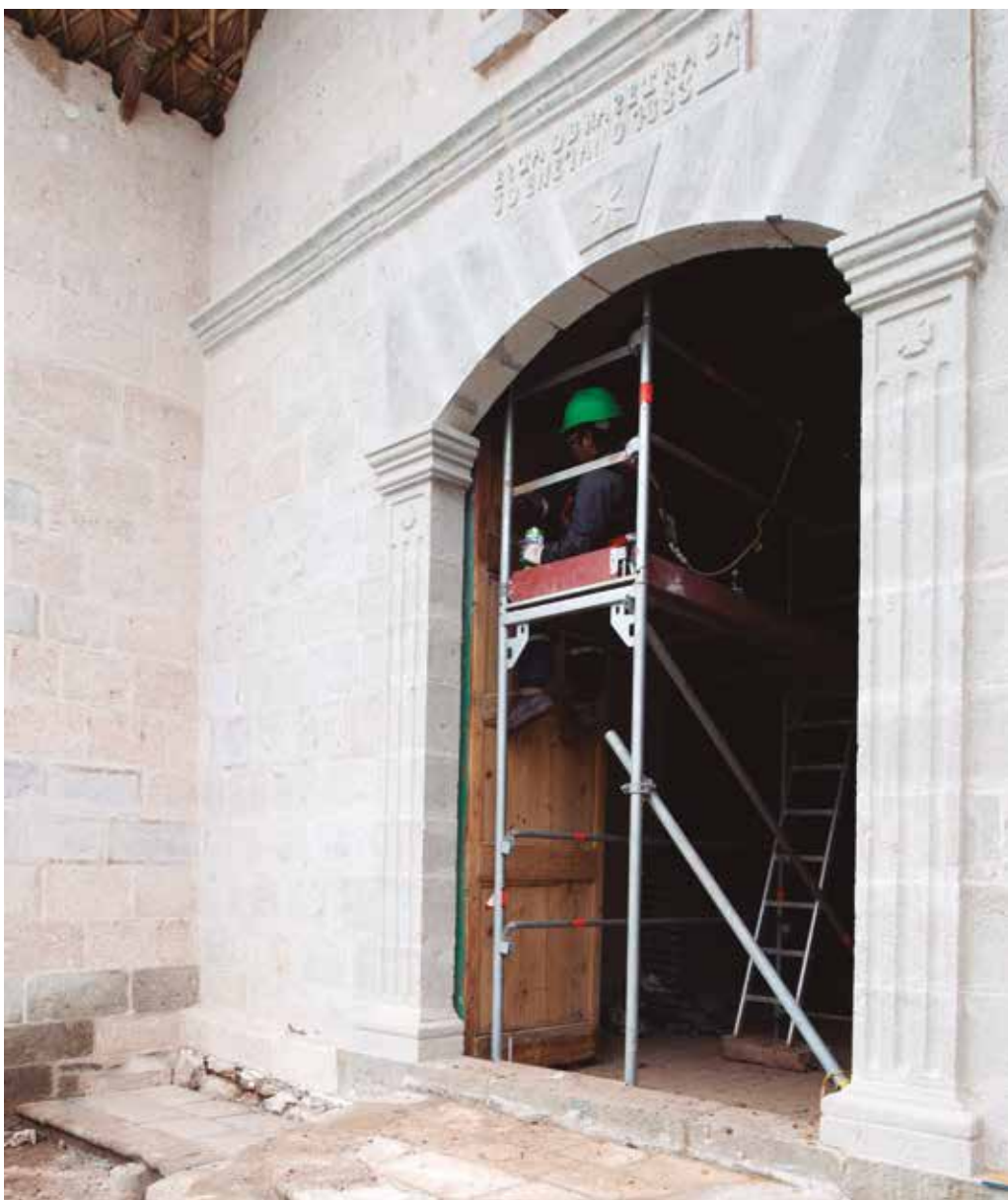
Consolidación de las antiguas gradas de piedra del acceso principal al templo. Consolidation of the old steps of stones in the principal acces of the church.
