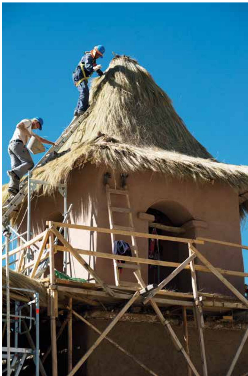
Torre campanario, durante la restauración. Bell tower during the restoration.
