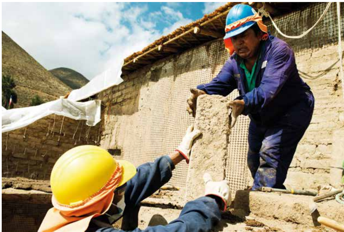
Muro del evangelio durante el proceso de restauración del templo. Gospel wall during the process of restoration of the church.
