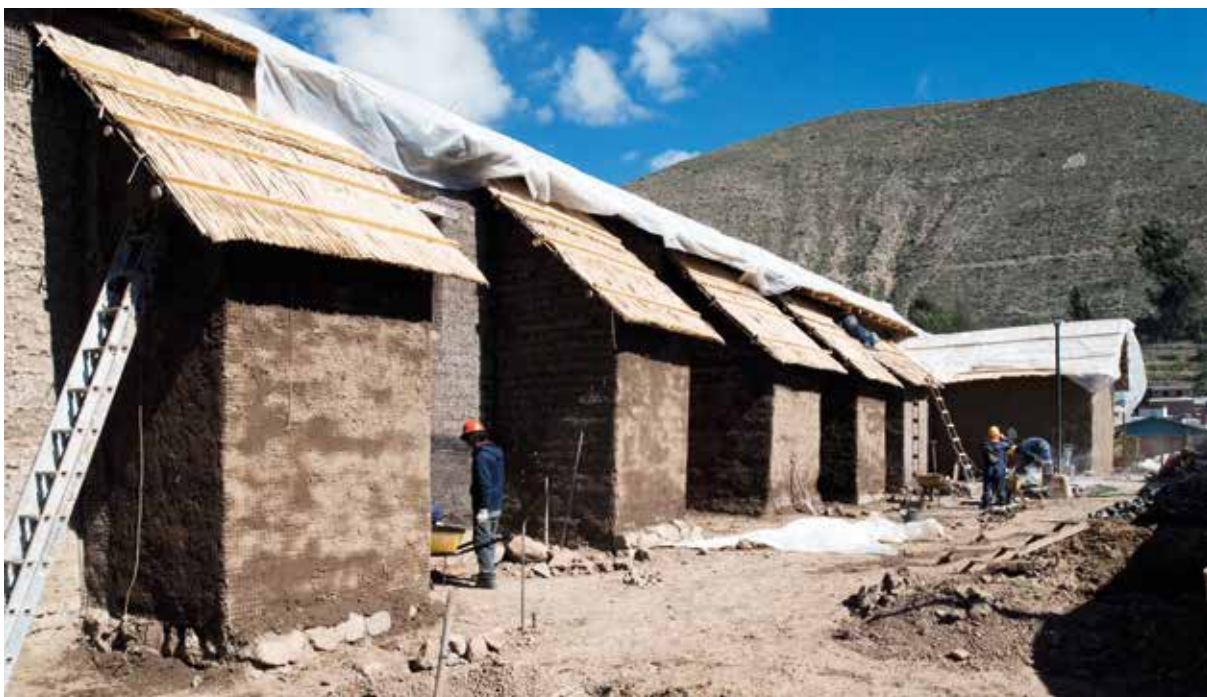
Muro de la epístola durante el proceso de restauración. Epistle wall during the process of restoration.
