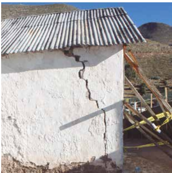
Daños en los muros del templo por los sismos del año 2001 del sur de Arequipa y del 2005 del interior de Iquique. Damages in the walls of the church induced by the earthquakes of the years of 2001 centered in the south of Arequipa and 2005 centered in the foothills of Iquique.
