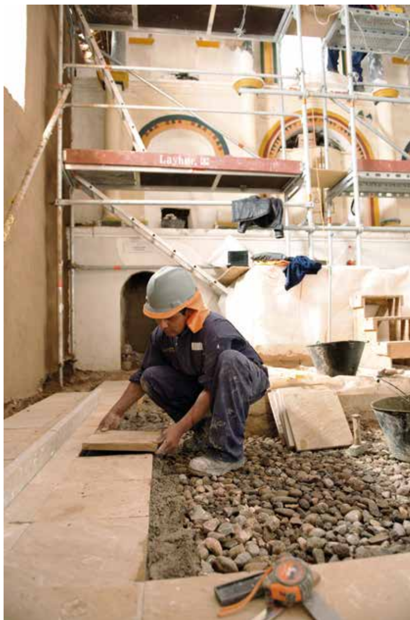
Reposición de pavimento original en el presbiterio del templo. Replacement of the original paving in the presbytery of the church.
