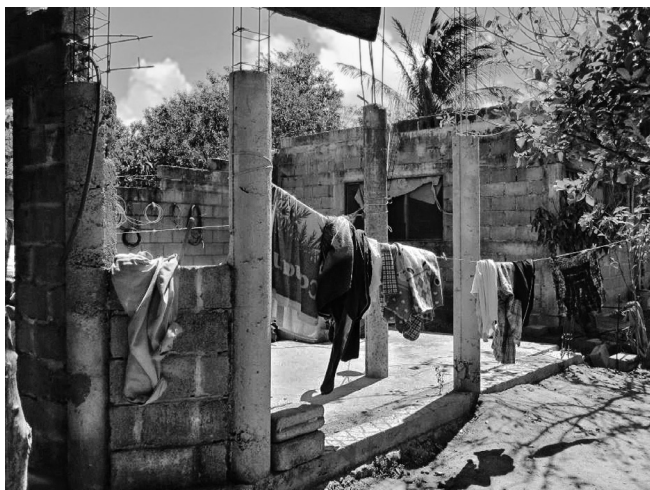
Imagen 11. Block para una ampliación. Foto: Georgina Sandoval.
