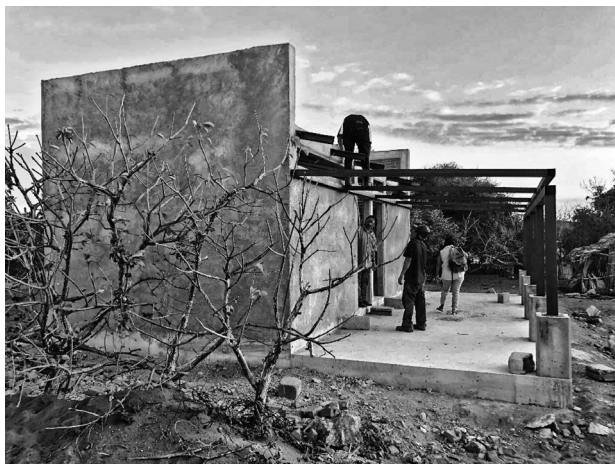
Imagen 12. Módulo nuevo, proceso de la obra. Foto: Georgina Sandoval.
