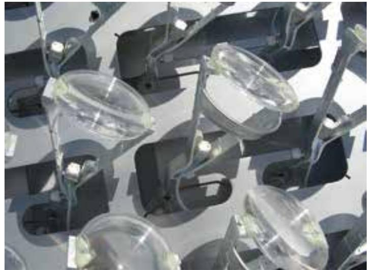
Figura 1.91: Captador de fibra óptica Parans©, Solar Decathlon 2012, Madrid. Captadores externos con lentes fresnel. Fuente: Archivo de la autora.
