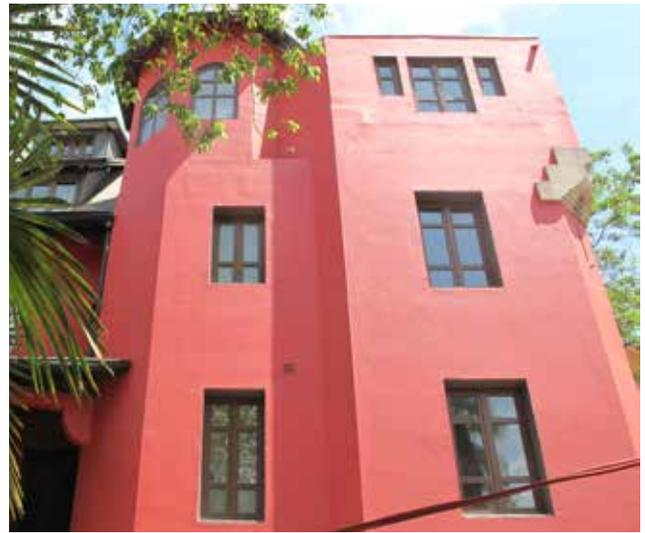
Figura 1.100: Arriba: Ejemplo real de intervención en un proyecto de rehabilitación en Santiago de Chile, imagen del cambio de ventanas antiguas de madera por sistemas nuevos de PVC y vidrio par. Fuentes: Hotel Casa Roja, archivo de la autora.
