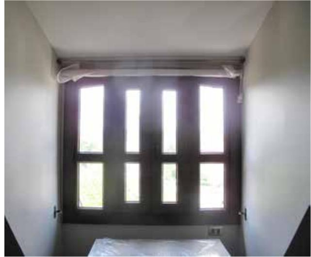
Figura 1.96: Ejemplo real de sustitución de las ventanas en un proyecto de rehabilitación en Santiago de Chile, la ventana original de madera y la ventana nueva de PVC con vidrio par o termopanel. Fuentes: Hotel Casa Roja, Archivo de la autora.
