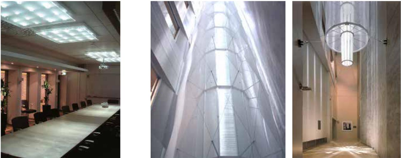
Figura 1.92: Emisor del luz natural sistema Parans. Proyecto de iluminación interior del estudio Carpenter/Lowings Architecture & Design. Fuentes: [www.parans.com](http://www.parans.com) y <http://carpenterlowings.com>.
