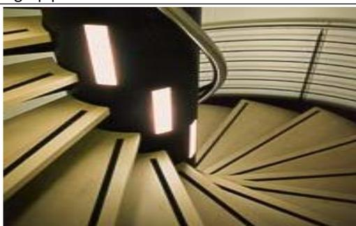
Derivado de los lumiductos, las *lightpipe* son un sistema altamente tecnológico que incorpora distintos materiales que juntos logran llevar la luz muy profundamente. En algunos casos son utilizados como pilares del luz puesto que alumbran durante todo el trayecto, no necesariamente al final de su recorrido.
