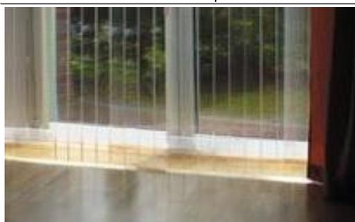
También basándose en el principio del lente Fresnel, existen materiales capaces de redireccionar la luz y por tanto impedir el sobrecalentamiento por radiación directa si impedir la vista hacia el exterior.
