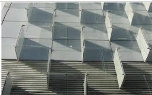
Los quiebrasoles son una textura extruida en el exterior de la envolvente de un edificio. Son prácticos no solo para impedir o controlar el sol sino las vistas. Pueden orientarse según la orientación necesaria de la fachada, para más o menos luz.
