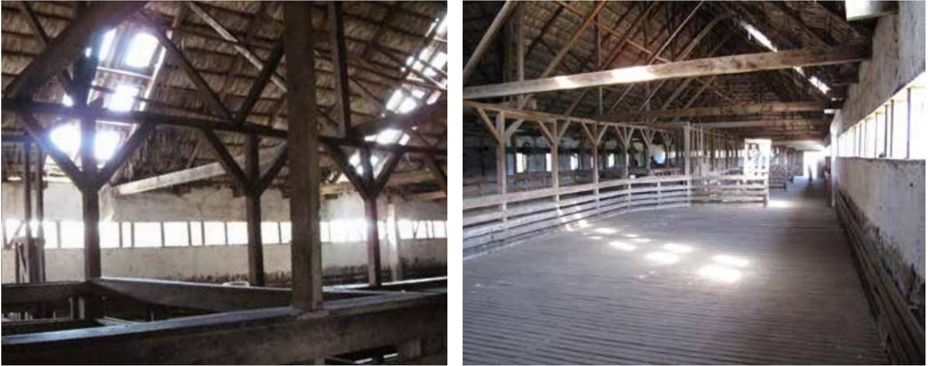
Figura 3.63: Interior del Galpón de Esquila de la Hacienda el Tangué, Norte Chico. La luz natural viene dada por lucarnas en la cubierta y perforaciones longitudinales de los muros. Fuente: Archivo de la autora.
