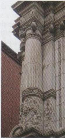
**Adosada.** La que se levanta adherida a un elemento constructivo vertical, muro o pilar, sin dejar espacio entre ambos. Cuando alguna de sus piezas se introduce en el elemento al que está adosada formando parte de ambos, se la califica además de *embebiada*, *entrega*, *entregada* o *de media caña*.
