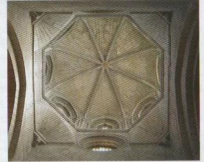
**Tabicada.** La que se construye con ladrillos puestos de plano unos a continuación de otros dando la impresión de un tabique volteado. Los romanos la utilizaban como cimbra permanente en la bóveda de hormigón. En España, los musulmanes las usaron con frecuencia y se han perpetuado en las bóvedas a la catalana. Se aplican a menudo en bovedillas de techos y escaleras.
