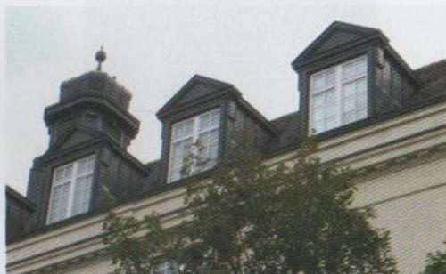
**Empotrada en la cubierta.** La encajada debajo del faldón de una cubierta o a ras de ella.
