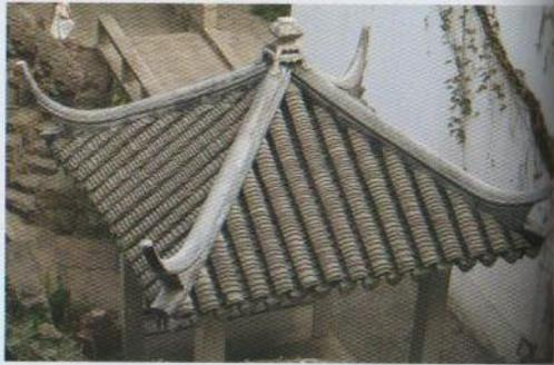
**Cubierta piramidal hexagonal u octogonal.** Variante de la piramidal. Presenta seis u ocho lados con un vuelo parabólico.
