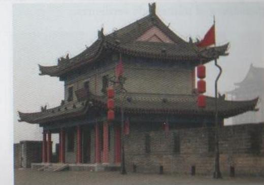
**Cubierta de armadura cruzada.** Cubierta de pabellón compuesta de varios niveles, algunos de los cuales incluyen en el mismo plano cubiertas perpendiculares entre sí.
