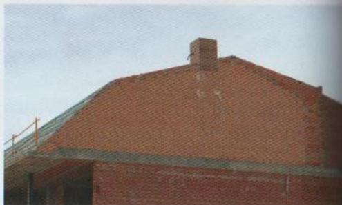
**Cubierta de semicopete, de copete truncado o de peto quebrantado.** Cubierta a dos aguas que aparece quebrada en un extremo de la cumbre, formando un triángulo. Puede incluir faldones quebrados en sus paños laterales.
