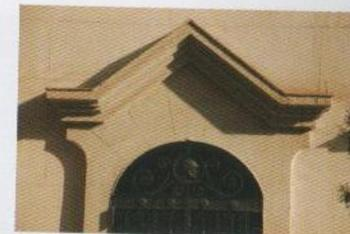
**Triangular.** El que tiene la forma de un triángulo equilátero.
