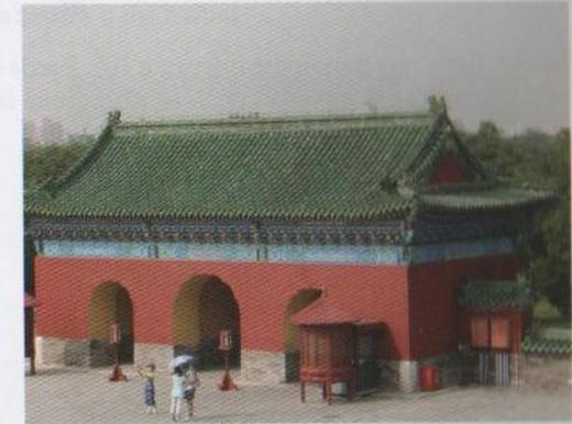
**Cubierta de pabellón compuesta de varios niveles.** Tejado a cuatro aguas con dos vertientes menores que incluyen un corte perpendicular y que tiene distintos pisos inferiores a cuatro aguas. Su número varía en función de la importancia de la construcción. En las murallas de Pekín llegaban a tener hasta tres niveles diferentes.
