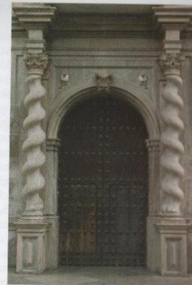
**Torsa.** Aquella cuyo fuste aparece decorado con molduras o estrías que la recorren helicoidalmente en torno a un núcleo cilíndrico central. Su uso abarca desde la antigüedad clásica hasta movimientos de los siglos XIX y XX como el Modernismo, en el que se realizaron piezas singulares.
