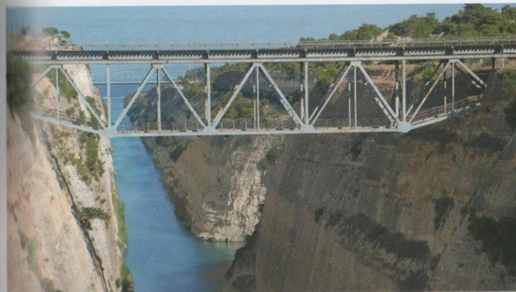
Armaduras de puente (celosía) que unen los extremos del Canal de Corinto, Corinto.
