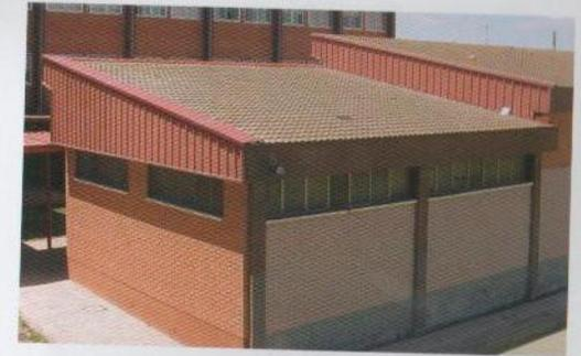
**Cubierta a dos aguas.** La que tiene dos vertientes unidas en la parte superior, en el caballete o cumbre, por lo que suele estar colocada sobre piñones o un hastial.
