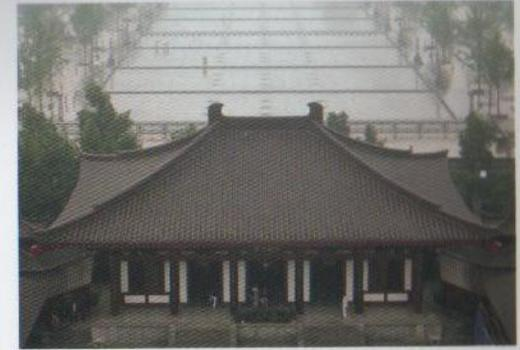
**Cubierta de pabellón compuesto.** Estructura a cuatro aguas con dos vertientes menores que incluyen un corte perpendicular.
