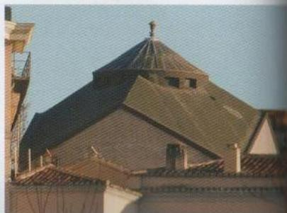
**Cúpula.** Bóveda engendrada por la rotación de un arco que cubre una superficie redonda, cuadrada, poligonal o elíptica.
