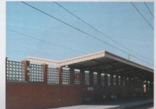
**Cubierta quebrantada.** La que tiene en sus vertientes dos o más faldones de pendientes distintas. Cuando tiene dos faldones en cada una de sus pendientes y el inferior tiene una más acusada que el superior, se denomina cubierta *a la mansarda* o *amansardada*. En este caso, lo más común es que tenga sólo dos faldones quebrados. La unión entre los planos se hace mediante las limas.
