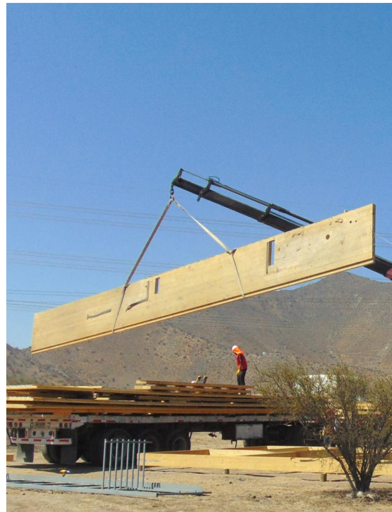
Construcción prototipo en Carén. Fuente: elaboración propia
