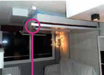
Compuestas, básicamente, por una plataforma o estructura metálica –recubierta con láminas de melamina– sobre la que reposa el colchón
