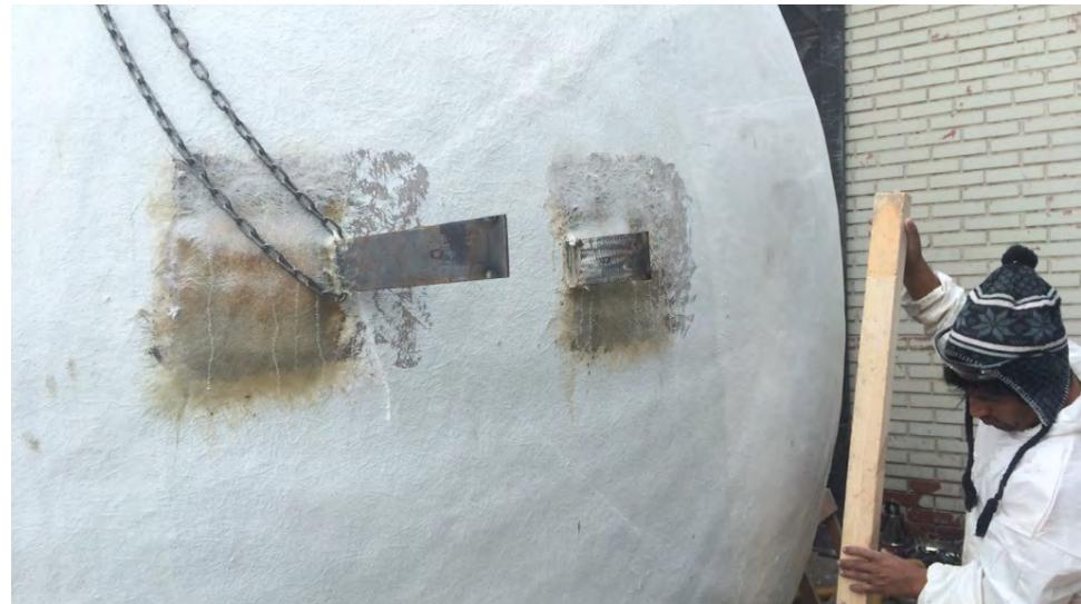
Imagen 30: Proceso de instalación de piezas a través de Laminado Manual. Fuente: Autoría propia.
