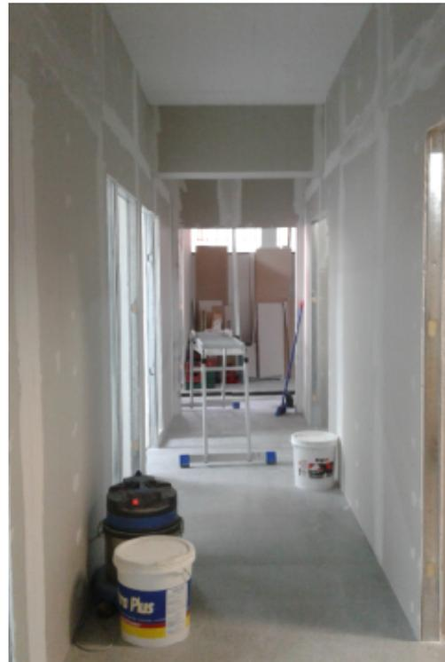
*Figura 51: Recubrimiento de juntas en placas yeso cartón II. Elaboración propia.*
