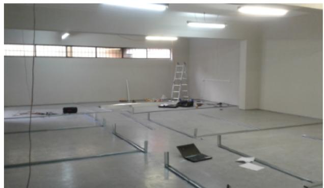
*Figura 47: Instalación Canales Metalcon. Elaboración propia.*
