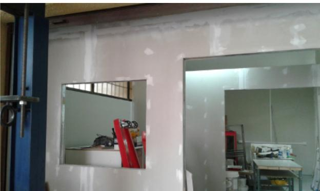
*Figura 50: Recubrimiento de juntas en placas yeso cartón. Elaboración propia.*
