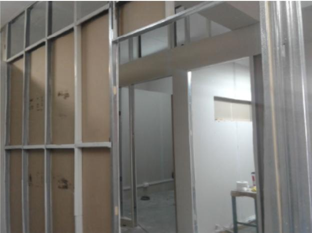
*Figura 49: Instalación de placas yeso cartón. Elaboración propia.*
