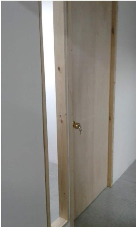
*Figura 56: Puerta con instalación de manilla. Elaboración propia.*
