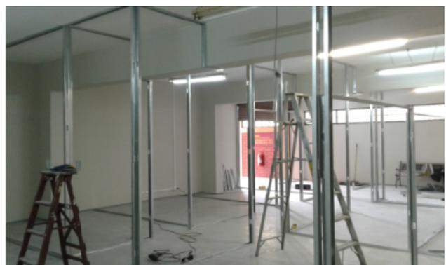
*Figura 48: Instalación Montantes Metalcon. Elaboración propia.*
