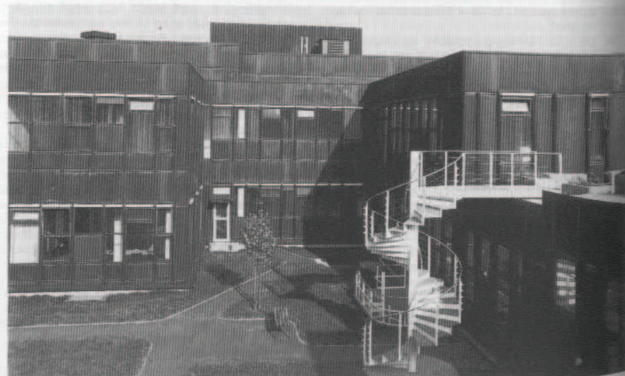
277 Woods y Schiedhelm, Universidad Libre, Berlín-Dahlem, 1963-1973. Sistema de cerramiento de acero cortén, elaborado por Jean Prouvé.
