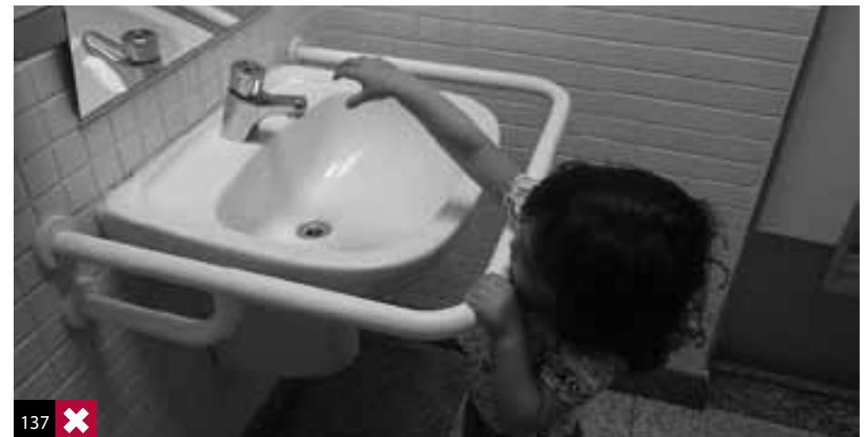
Foto 137: barra que no permite la aproximación a la grifería. Los elementos de apoyo no deben colocarse frente a un lavamanos.
