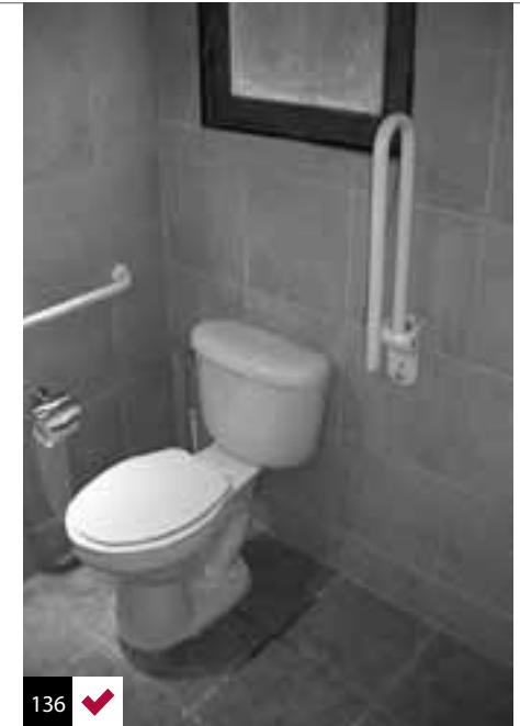
Foto 136: barra abatible que permite la transferencia y su posterior uso como apoyo.
