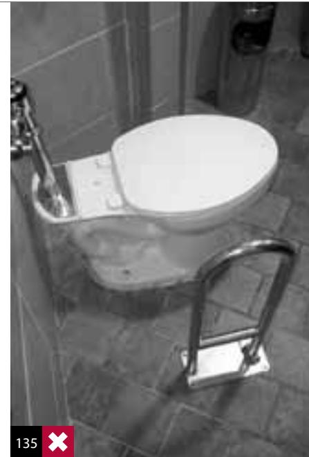
Foto 135: barra de muro instalada al piso. No cumple su función.
