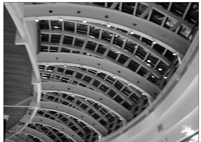
Figura 01: Estrutura da Cobertura - Moinhos Shopping - RS.
