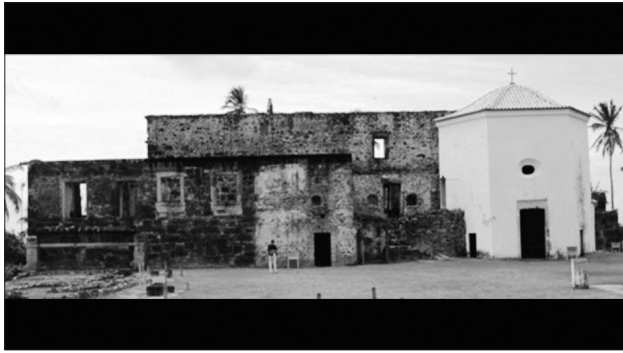
Figura 1. Fachada principal do Castelo Garcia D'Ávila.
