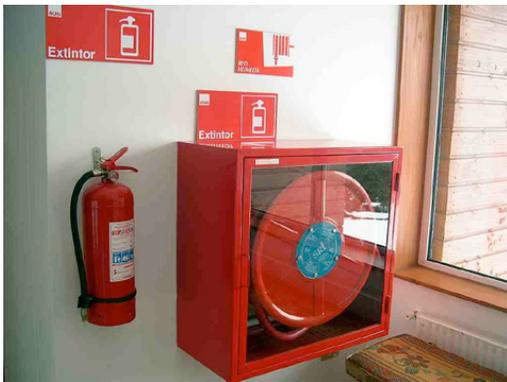
Es un sistema de cañerías auto alimentadas con agua cuya función es la primera intervención en caso de incendio. La red húmeda consta de una manguera con un pitón de distintos tipos en el extremo. Al abrir la llave de paso, el agua llega hasta el pitón. La red húmeda debe conectarse al sistema de distribución de agua del edificio, no a la red de incendio.
