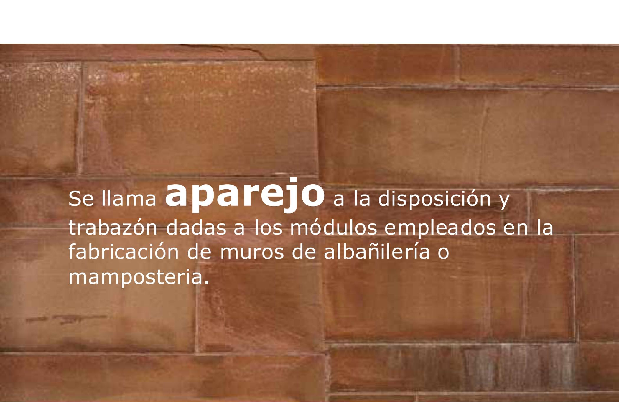
Se llama **aparejo** a la disposición y trabazón dadas a los módulos empleados en la fabricación de muros de albañilería o mampostería.
