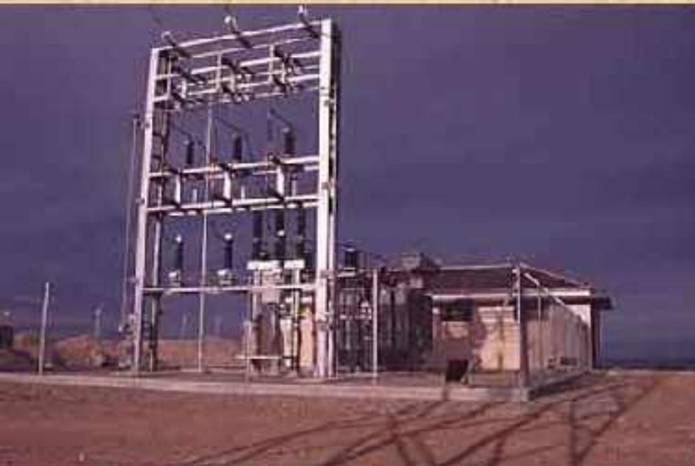
**1. Subestacion transformadora.** Destinada a transformar la corriente alterna de una tensión determinada, en corriente alterna de otra tensión diferente.
