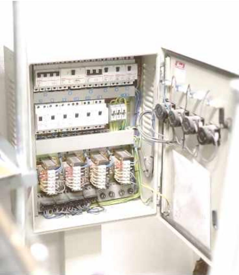
Ubicados a una altura mínima de 0.60 m y máxima de 2.00. Son equipos eléctricos que concentran en ellos dispositivos de protección y maniobra. Desde ellos se puede proteger y operar toda la instalación o parte de ella (con disyuntores, fusibles, protectores térmicos, diferenciales). En el tablero deberá indicarse la tensión de servicio (v), la corriente nominal (A), número de fases (en CA mono y trifásico).
