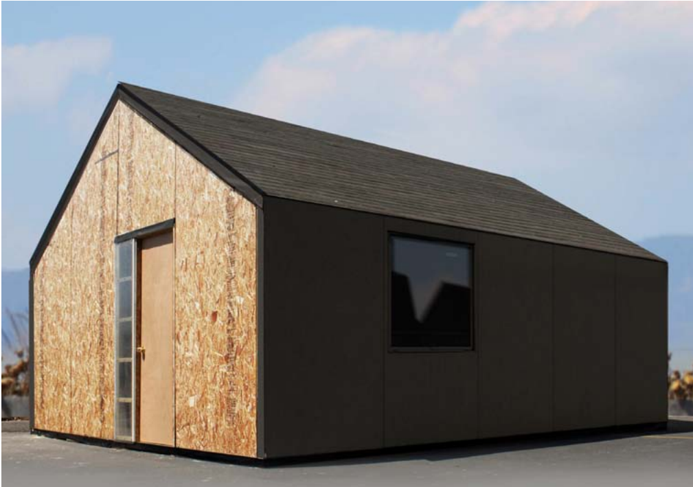
VISTA EXTERIOR ACCESO
