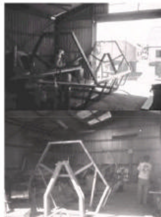
CONSTRUCCION DEL CONTENEDOR ESCALA 1:1 NOVIEMBRE 1998
