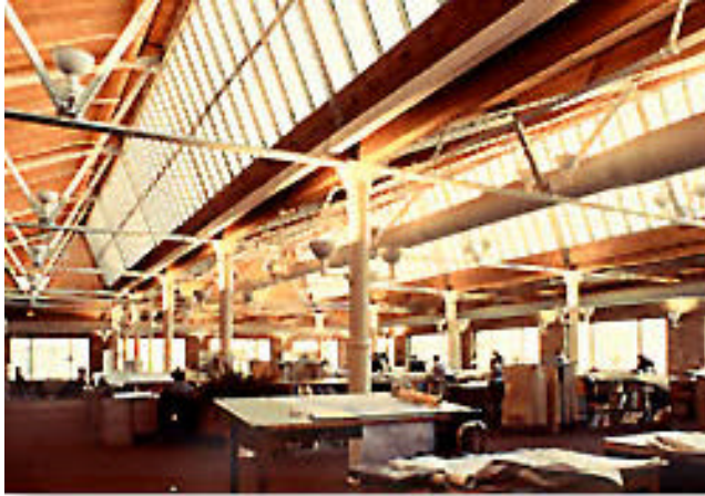
Fig. 10.4.c Nave con iluminación cenital semi-vertical
