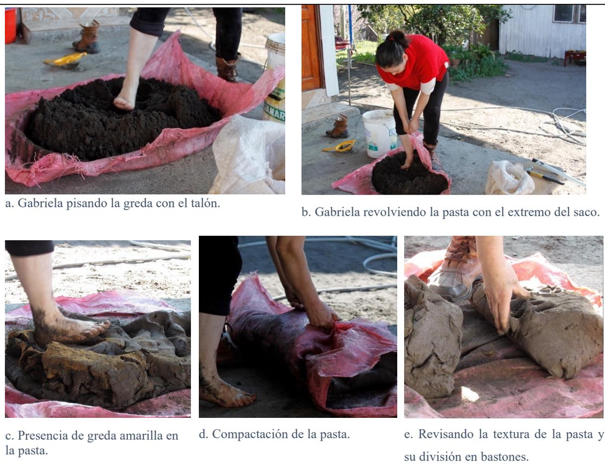
Figura 21: Secuencia operacional de la mezcla de las materias primas y su amasado con los pies GG.
