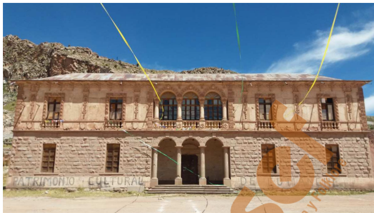
Figura 1. Casa de hacienda, Comanche. Foto: Gabriela Behoteguy, 2018.
