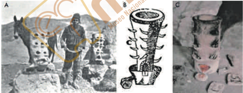
Figura 1. Ejemplos etnográficos y etnohistóricos de huayras : a) metalurgista anónimo en Bolivia (Peele, 1893:9); b) dibujo de una huayra colonial realizado por Alonso Barba (1923[1640]: 199); c) reconstrucción en el Museo Nacional de La Paz. Fuente: Zori y Tropper (2010).
