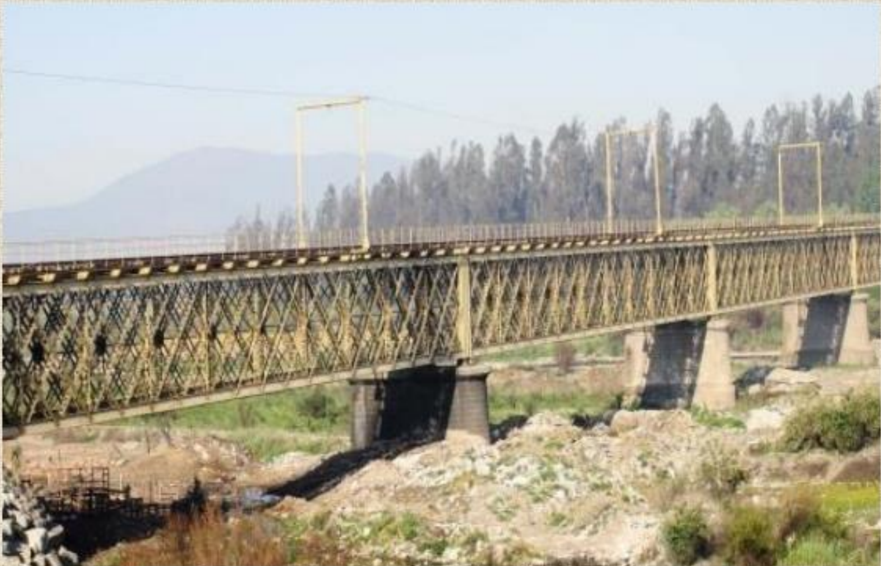
Puente Ferroviario, siglo XXI
