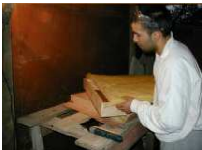
Rellenando con aislante
