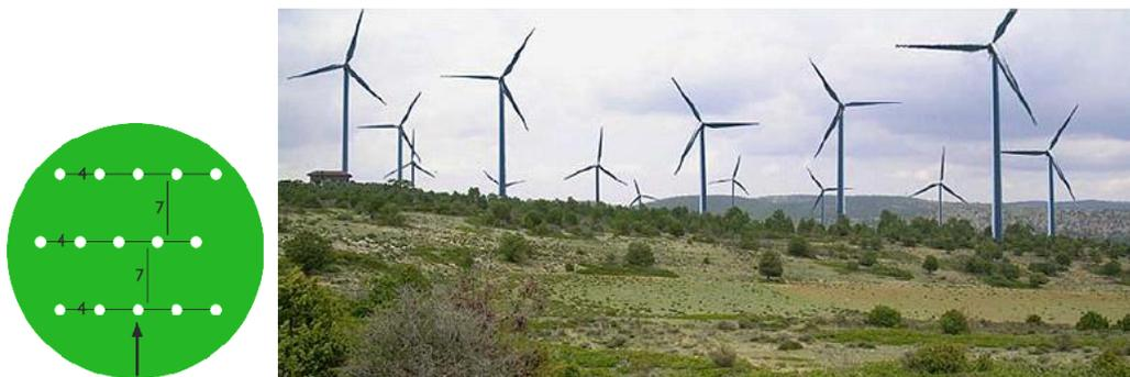
Figura 7: Distribución básica de aerogeneradores
