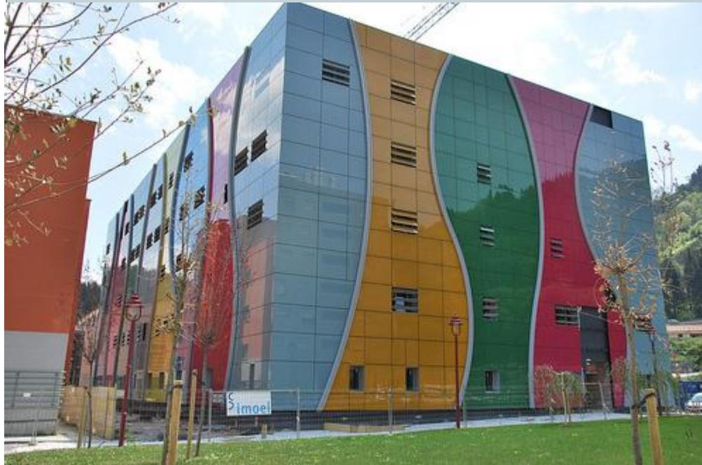
Fachada ventilada diseñada bajo un criterio de doble piel, combinando cerramientos interiores de ventanas con una fachada ventilada a modo de piel exterior. Las ventanas corresponden al cerramiento interior junto con la tabiquería, y están realizadas con carpintería de aluminio y vidrio aislante.
