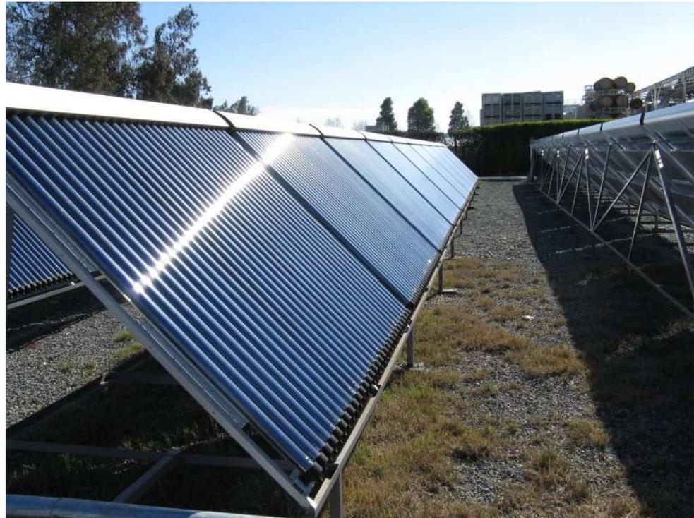
Colector plano y colectores de tubo evacuado
