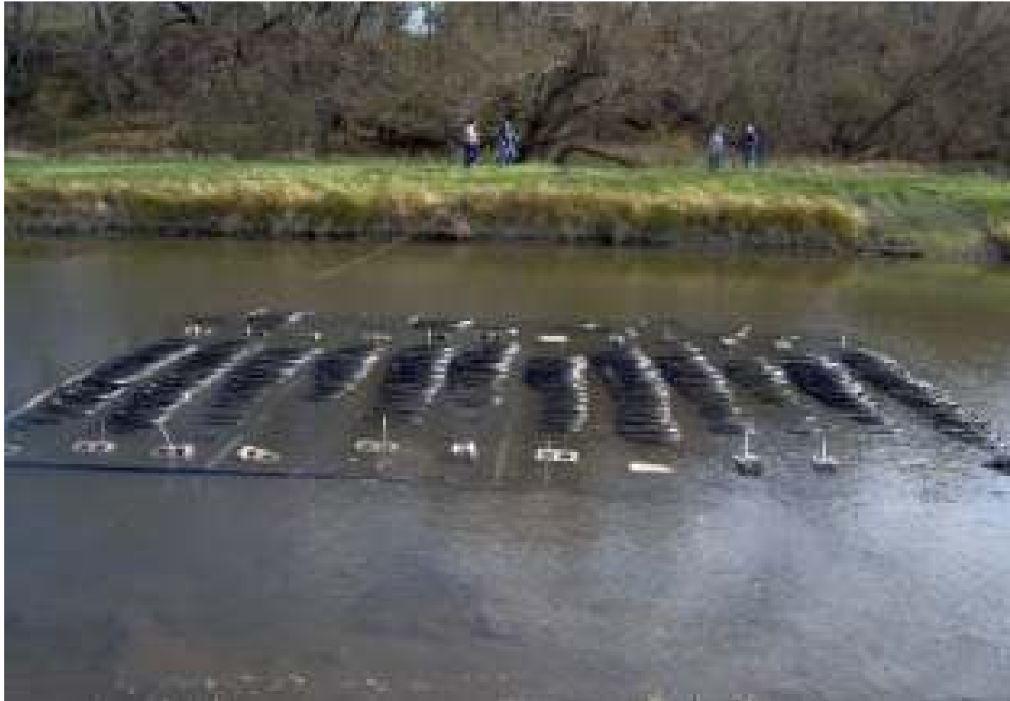
Instalación de loop sumergido en una laguna
