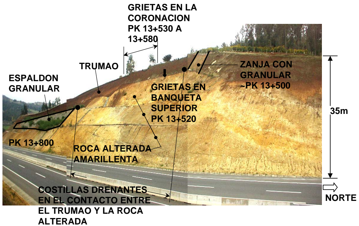
Fig. 2 Corte Poniente que experimentó Deslizamientos en el pasado y Zona de Grietas con Reactivación de un Deslizamiento (Agosto 2004).
