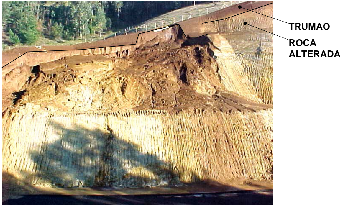
Fig. 1 Deslizamiento en el Corte Poniente PK 13+200.
