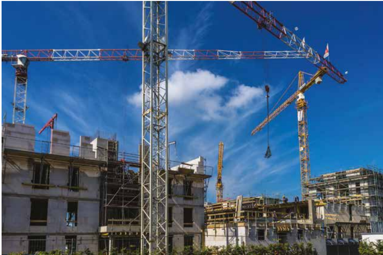
FIGURA 5. Construcción de la obra
