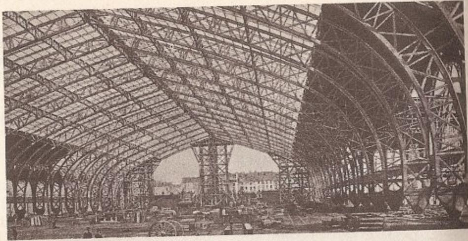
3: El Salón de las Máquinas en la Exposición de París de 1889 fue una de las más elegantes estructuras ingenieriles: en cuanto a su técnica superaba cualquiera de las cubiertas de estaciones de ferrocarriles en el refinamiento de su diseño. Creada por un arquitecto, Dutert, y un ingeniero, Contamin, tenía quizá mayor significado que la Torre Eiffel más audaz, levantada en la misma época. Hay que recordar que el rascacielos americano de estructura de acero fue un producto de ese mismo período.
