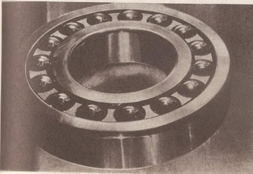
1: Rodamientos de bolas automáticos. Alto grado de precisión y refinamiento en uno de los aspectos más esenciales de la máquina. La belleza de las formas geoméricamente elementales. Perfección del acabado y ajuste, aunque ya presentes en la artesanía fina, se hizo corriente —y esencial— en los productos de la máquina.
